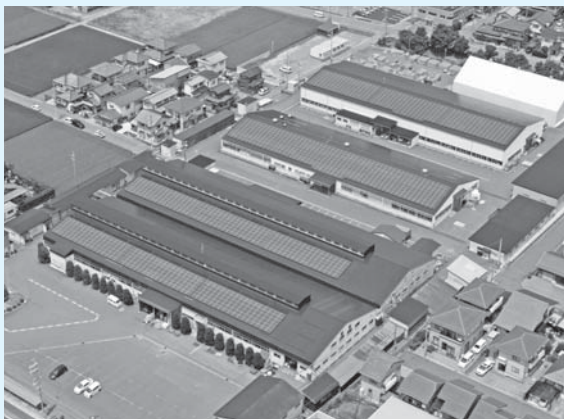
工場の屋根を利用した太陽光発電システムの施工例
